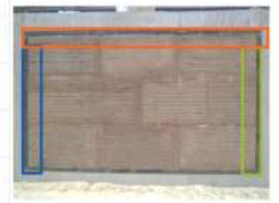
Isollements de jonction mesurés sur la paroi pisé de 30 cm
