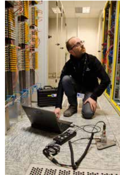
Surveillance vibratoire pendant la démolition des cuves à fioul
